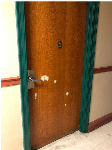
Hallway / Unit entry door
